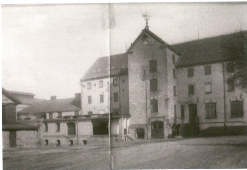
Venstre foto: Tårn med ur og nedgang til maskinværksted. I højre side trappe op til brygmester-kontorerne. I venstre side nedkørsel til Silkeborgvej og gml. vandfabrik.
