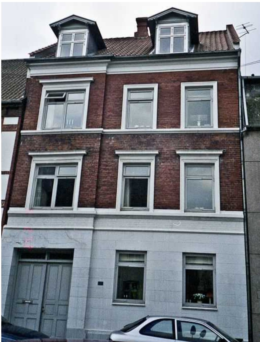
Figur 12 Wilstersgade 12 med moderne vinduer tilbageført til dannebrogsvinduer i 2010, 08-02-2002 Torben Aastrup
