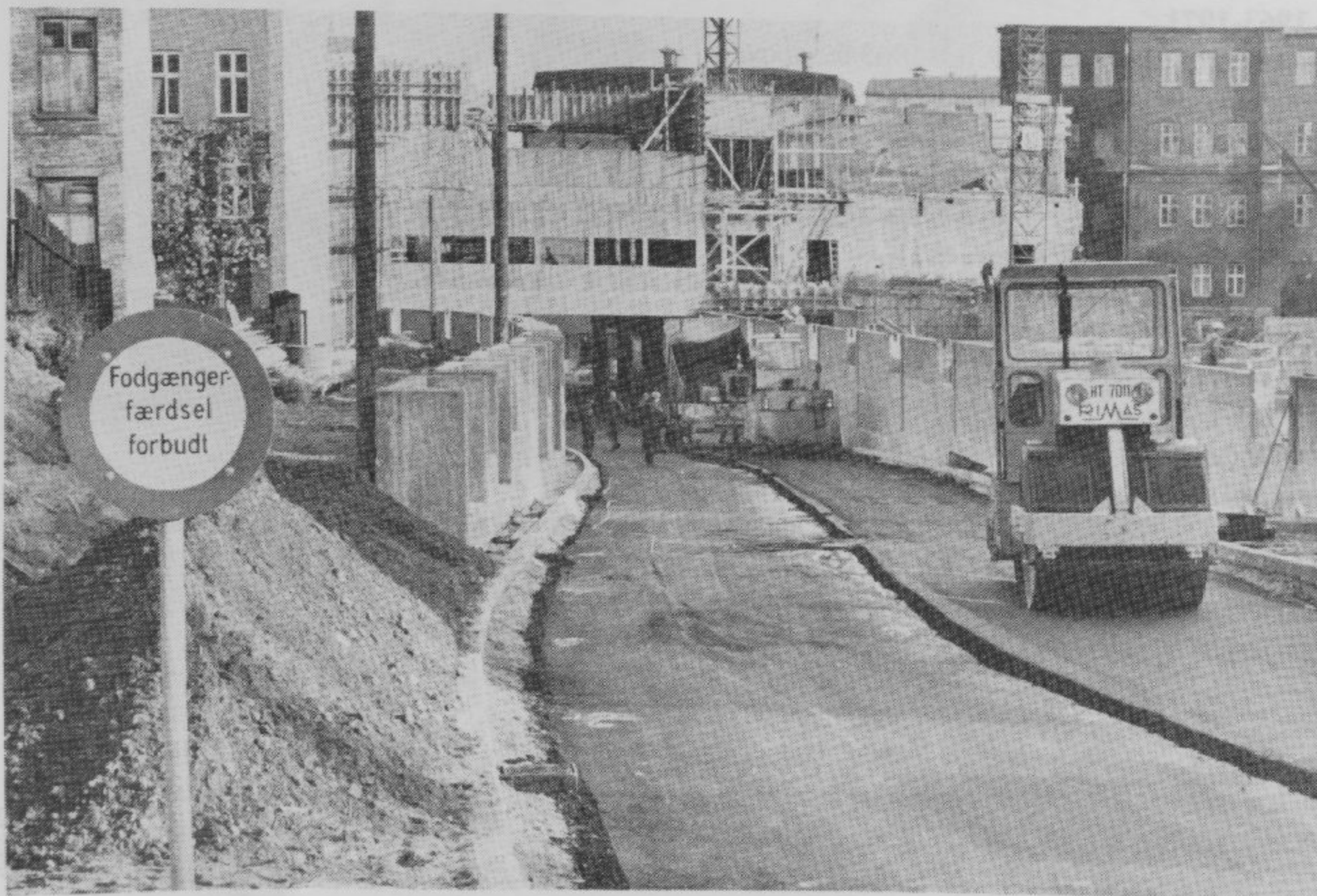
Busgaden under anlæggelse, oktober 1971. Foto Jens-Kristian Søgård. Lokalthistorisk Samling.
