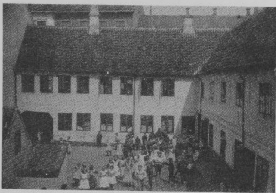
Den tidligere Borgerpigeskole, Vestergade 23, fotograferet foråret 1907. Klasser fra Nørrebrogades Skole er midlertidigt installeret i bygningen. Lokalthistorisk Samling.
