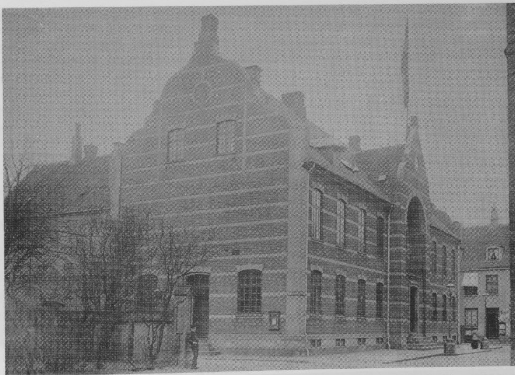
Rådhuset på hjørnet af Mejlgade og Domkirkepladsen, fotograferet omkring 1900. Sidebygningen i baggrunden til venstre er det tidligere arresthus, hvor stadsingeniørens kontor havde lokaler fra 1908 og til flytningen til selve rådhuset. Som det ses, havde politistationen indgang i gavlen. I februar 1933 vedtog byrådet at indrette et lokale i loftsetagen over stadsingeniørens kontor som „kriminalmuseum“ til opbevaring af „en hel del genstande af kriminalistisk interesse“, som politiet havde samlet sammen gennem årene, og som der ikke længere var plads til i tinghuset. Museet var dog ikke tilgængeligt for offentligheden - men stadsingeniørens personale havde fornøjelse af det, til kontoret flyttede over i nummer 3. Lokalhistorisk Samling.
