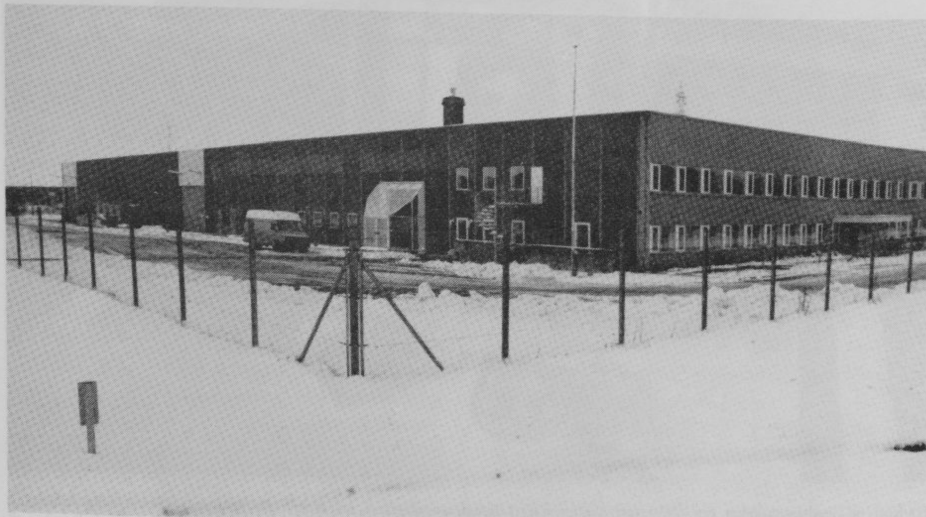
Den nye materialgård på Edwin Rahrs Vej fotograferet februar 1994.
