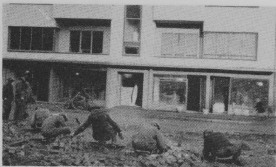
Brolægningsarbejde på Åboulevarden, oktober 1933. Håndværket er det samme som altid: både brolæggerhamre og „kraveknappen“ genkendes fra 1895 og 1916. Lokalthistorisk Samling.
