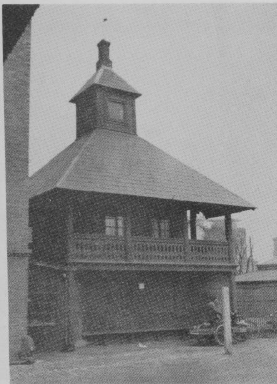
Lodshuset fotograferet september 1935, ikke længe før det blev revet ned. Det var byens ældste lodshus, opført 1805 og ombygget 1862. Senere opførte Århus Dampmølle bygningen klods op af det. Stads- og havneingeniørens lokaleforhold har været beskedne, da huset i 1870'erne stadig brugtes også til sit egentlige formål. Hvis Obel har haft personale ansat her, har det ikke været stort. Lokalhistorisk Samling.
