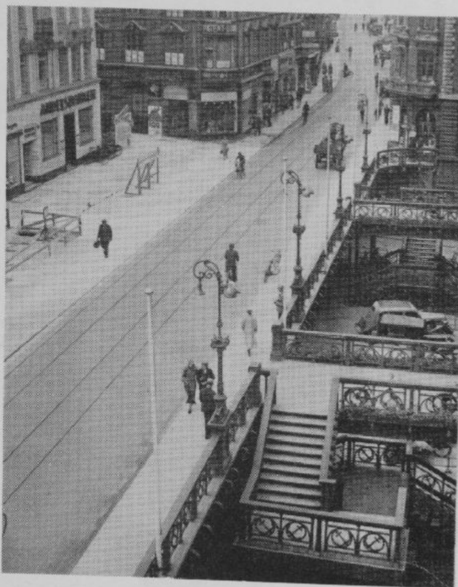
Skt. Clemens Torv fotograferet fra nord under ombygningen - nogle ville måske sige hærværket - 1938-1940. Til venstre er brodækket udbygget, til højre fremtræder konstruktionen stadig åbent, som den bro den er og med sit støbejernsrækværk med skt. clemensankrene intakt.
