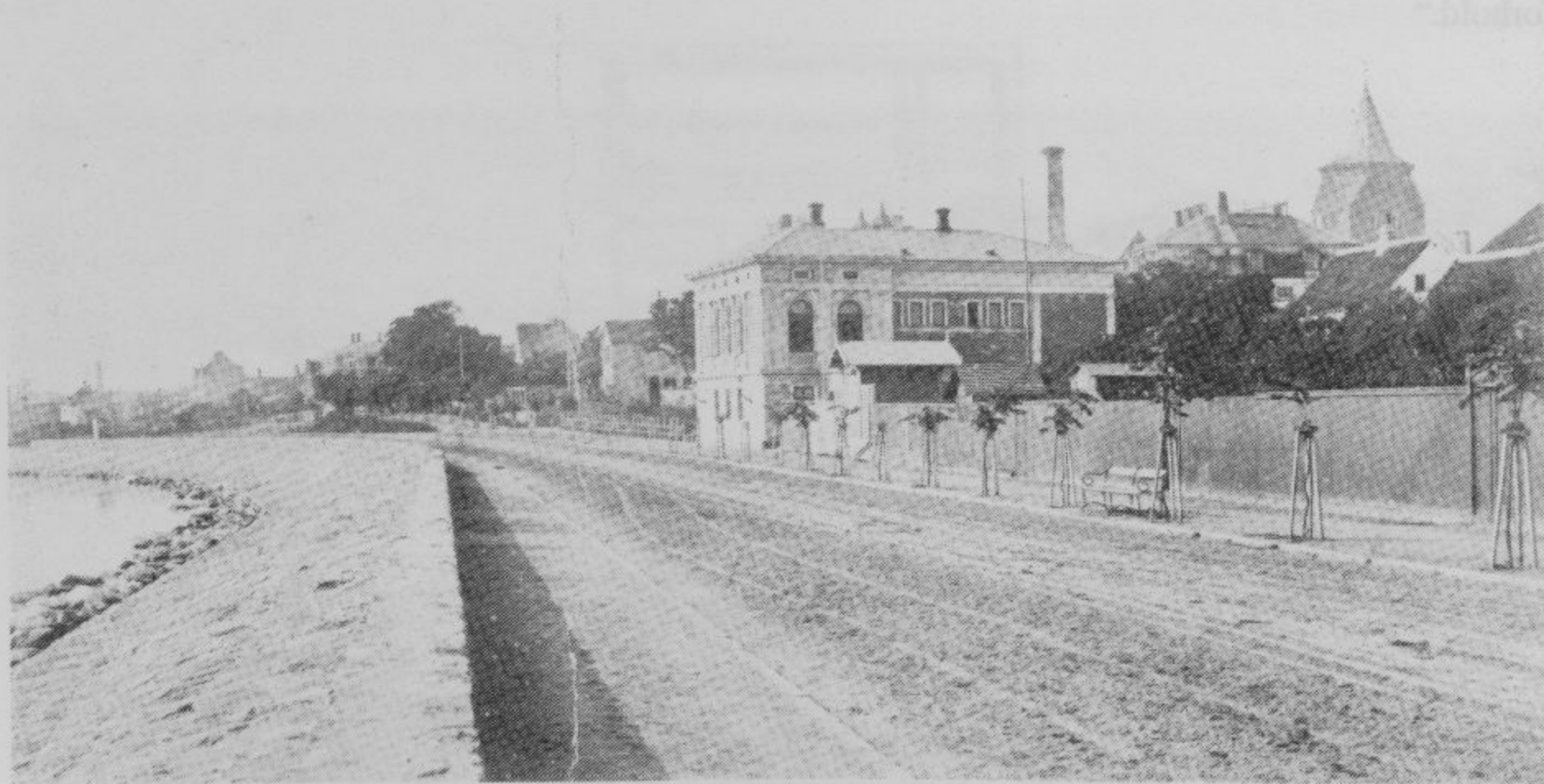
Kystvejen omkring 1873, set mod Skolebakken. Macadamisering eller chaussering var betegnelser for en 20-25 cm. tyk belægning med skærver udlagt i flere tynde lag, der tromledes hver for sig, med sand eller grus til at udfylde fugerne mellem skærverne. 1923-1925 blev Kystvejen brolagt med den såkaldte chaussébrolægning, dvs. brolægning med omkring 10 cm. store, kubiske sten i et 2-3 cm. tykt sandlag oven på gammel chaussé eller et betonfundament. Lokalhistorisk Samling.
