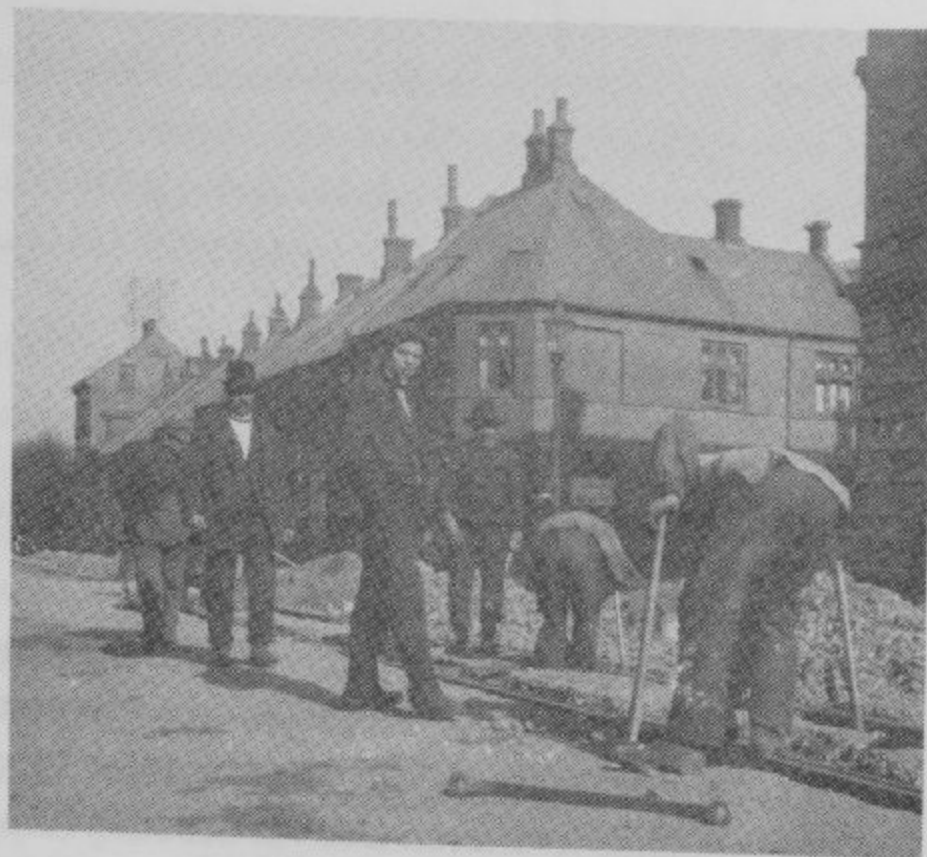
Der lægges sporvognsskinner i M. P. Bruungsgade ved hjørnet af Jægergårdsgade 1904. Århus fik en hestesporvognsrute fra Banegården til Store Torv i 1884, da Skt. Clemens Bro var opført. Den var ingen større succes og blev nedlagt i foråret 1895. Aktieselskabet Aarhus Elektriske Sporvej fik i foråret 1903 25 års koncession på sporvejsdrift i Århus og indledte 7. juli 1904 kørslen på den 4,35 km. lange rute fra Dalgas Avenue til Trøjborgvej; med en udvidelse af Guldmedegades bredde kom man her om ved det problem, som i sin tid havde standset Obels projekt, de trange gader i den indre by. Denne gang var sporvognene kommet for at blive, fra 1. januar 1928 drevet af kommunen, der havde overtaget selskabet og førte det videre under navnet Århus Sporveje. Lokalthistorisk Samling.
