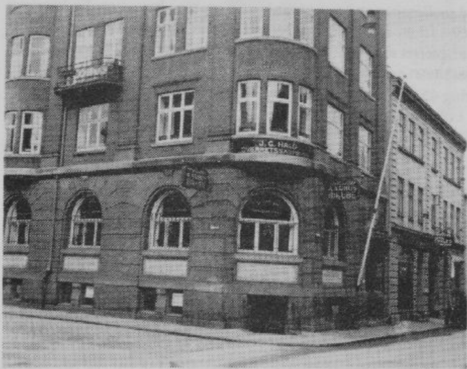
Hjørnet af Rosengade og Mejlgade fotograferet juni 1934. I banklokalerne i stueetagen indrettedes efter kommunens køb af ejendommen lokaler til byrådskontoret, mens stadsingeniørens kontor fik plads i de øvrige etager. Lokalhistorisk Samling.
