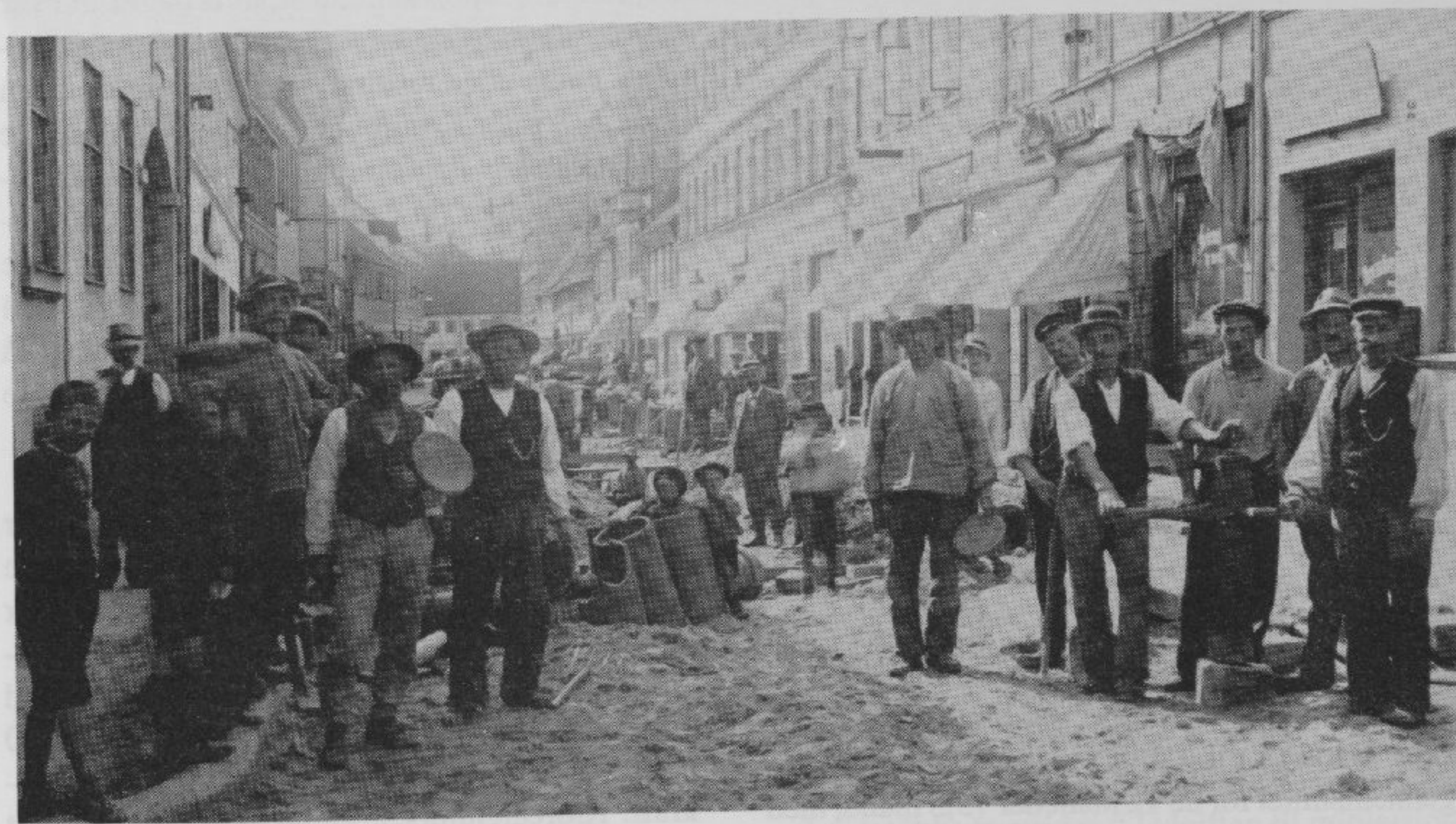
Kloak- og brolægningens arbejde i Vestergade omkring 1916. Fotograferet mod vest fra hjørnet af Grønnegade. Til højre et hold med deres firmandsstempel. „Vægten er sædvanlig ca. 90 kg, og stemplet føres, som det ligger i navnet, af fire mand, af hvilke en som formand styrer stemplet og leder stødningen.“ (A. R. Christensen, Veje og Gader , København 1943, p. 276). Det er sandsynligvis formanden, der her ses til venstre i gruppen, med hånden på det opadvendte håndtag, slagene styres med. Brolæggerstole og -hamre genkendes iøvrigt fra Søndergade i 1895. Billedet er gengivet efter et postkort med påskrift „S. P. Pedersen (entreprenør)“. Brolæggerne S. P. Pedersen & S. Christian Hansen fik ifølge Beretningen 1916-1917 det nye brolægningens arbejde i entreprise dette regnskabsår. „Vestergades ombrolægning er fortsat, idet strækningen fra Møllesti til Garvergyde har fået ny brolægning - kørebanen brosten I, fortovene kantsten I og betonfliser. Efter at efterstødningen er udført i sommeren 1917, blev kørebanen overtjæret for at tætte fugerne. Gadens middelbredde er 9,5 m, længde 137 m.“ Beretningen oplyser også, at kloakerne er blevet eftersat og delvist omlagt og sænket i samtlige ombrolagte gader, og at: „De hyppige opgravninger for gas- og særlig elektricitetsledninger bidrager i høj grad til at vanskeliggøre gadernes vedligeholdelse.“ Århus Elektricitetsværk var blevet anlagt ved siden af gasværket i vinteren 1900-1901 og taget i brug fra januar det sidstnævnte år, i hvilket Søndergade og Ryesgade som de første fik elektrisk gadebelysning. Lokalhistorisk Samling.
