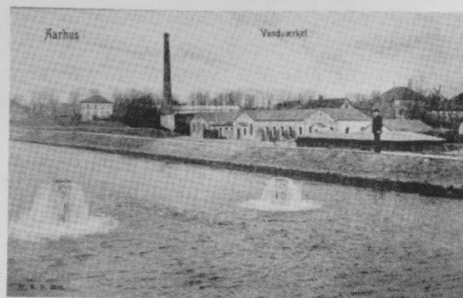
Vandværket som motiv på et postkort, fotograferet omkring 1910. Med overgangen til grundvand var bundfældning blevet overflødig, og bundfældningsbassinet blev for størstepartens vedkommende omdannet til filter. Fem lavtliggende filtre omdannedes til rentvandsbeholdere og blev overdækket i 1904. Man kunne nøjes med at filtrere grundvandet én gang. Lokalhistorisk Samling.
