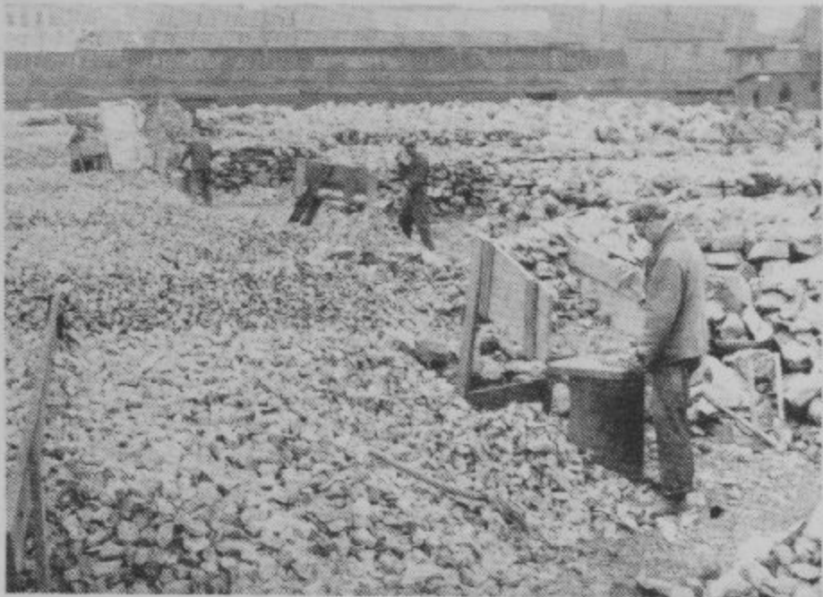
Skærveslagning på materialgården 1940. Metalringen skal forhindre skærvestykkerne i at fare til alle sider ved knusningen.
