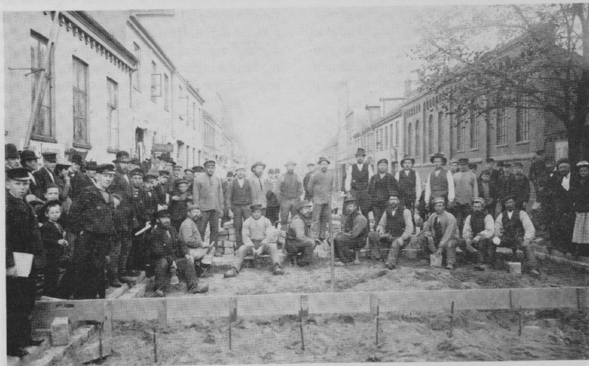
Brolægningsarbejde i Søndergade 1895. Brolægningen i Rymsgade, Søndergade og på Skt. Clemens Torv blev retableret for 2.285,53 kr., da sporvognslinien, der blev startet ved åbningen af Skt. Clemens Bro i 1884, var nedlagt og skinnerne fjernet. 25 gange 18 gange 14 cm. kampesten er ved at blive lagt i brolægningssandet. „Efter at brolægningssandet er spredt ud, anbringes først fortovenes kantsten, derpå lægges skiftet eller skifterne af brosten langs rendestene og til sidst skifterne tværs over kørebanen, idet der begyndes ude ved begge rendestene og afsluttes ved gademidten. Kørebanens overflade, der skal være hvælvet på tværs og have et jævnt fald på langs af gaden, afsættes ved hjælp af henholdsvis en skabelon og snore. På billedet ses 9 brolæggervende, hver med en brolæggerhammer i hånden. Nogle af svendene sidder på den énbenede brolæggerstol, „Kraveknappen“. Bag svendene står 10 arbejdsmænd, der dels lægger materiale til rette til svendene, dels banker eller støder brostenene på plads med et firmandsstempel, en brolæggerjomfru. Den samlede arbejdsstyrke kan ikke have arbejdet på dette sted alene, men har antagelig arbejdet i to hold, idet man ofte begyndte en brolægning midt på gadestrækningen og derpå arbejdede i hver sin retning.“ (Århus byhistoriske Udvalg, Trafik i Århus - før og nu 1976, p. 148) Lokalthistorisk Samling.
