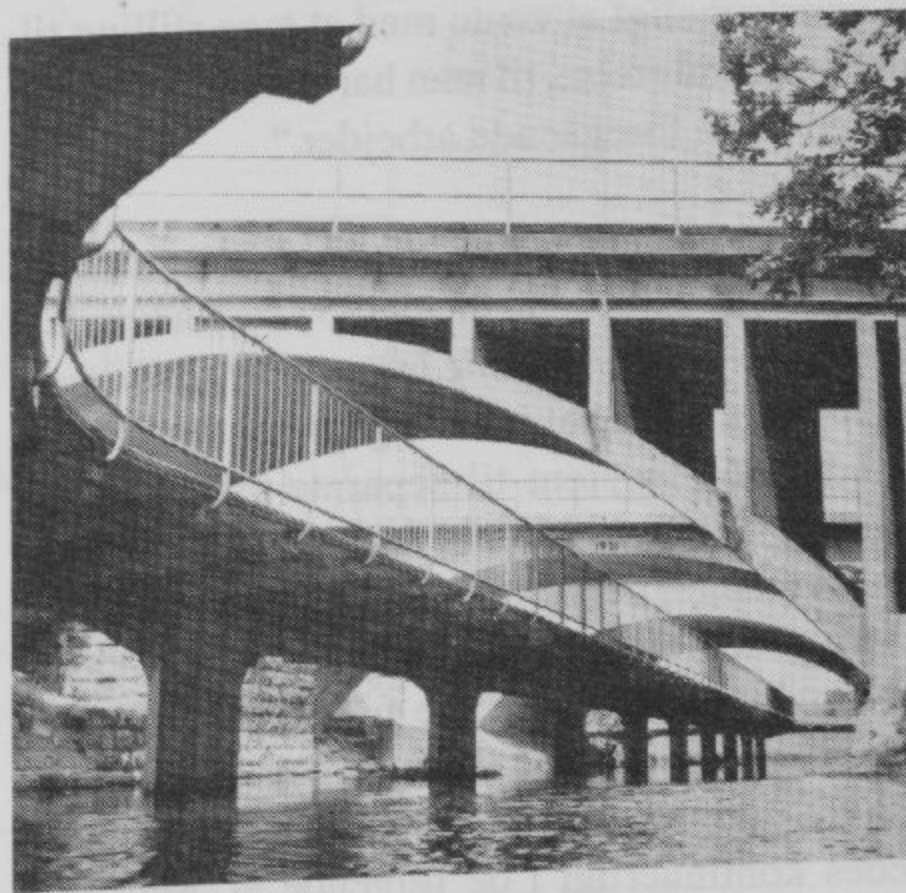
Fiskerhusbroen under de tre jernbanebroer fotograferet juni 1956. Lokalthistorisk Samling.
